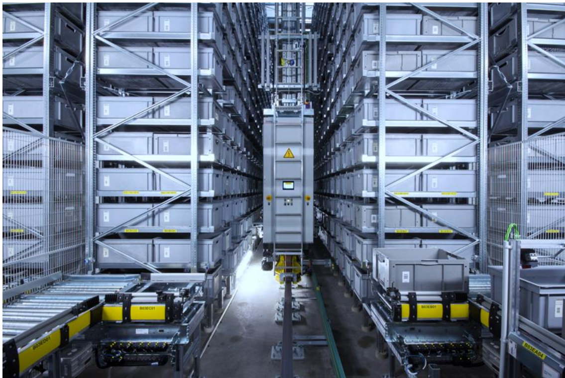
Automatisches Kleinteilelager mit Regalbediengeräten ©Unitechnik
