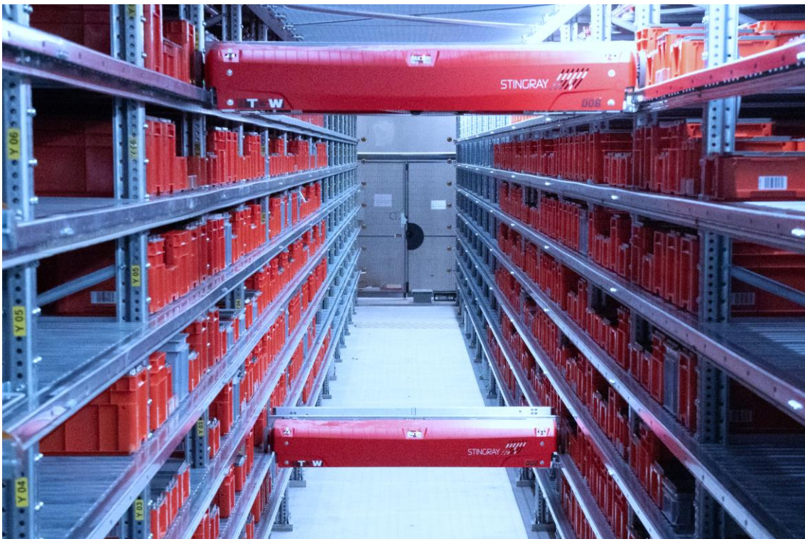
Shuttle-Lager mit Fahrzeugen, die mittels Lift die Ebene wechseln können ©Unitechnik
